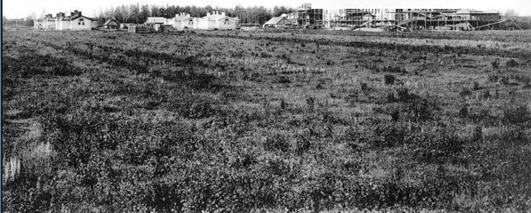
Поселок Серезино в строительный период 1911 г.
