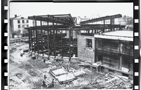
Начало строительства учебно-лабораторного корпуса.
