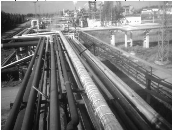
Рис. 1. Фотографии трубопроводов Ярославского НПЗ, изолированные пенлитом, белый цвет, Ду 159 и 210 мм,
