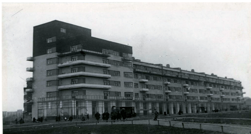
Рис.2. «Дом-корабль», архитектор Д. Ф. Фридман, 1930 г.// ИОКМ, 67621-8
